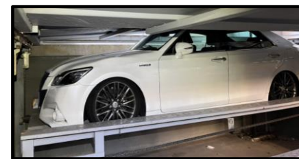
制御装置劣化による車両損傷
