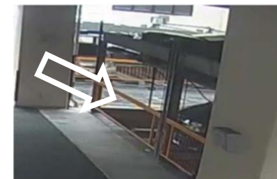
ワイヤロープ破断による車両落下
