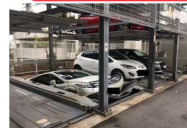
電動機の劣化による車両落下
